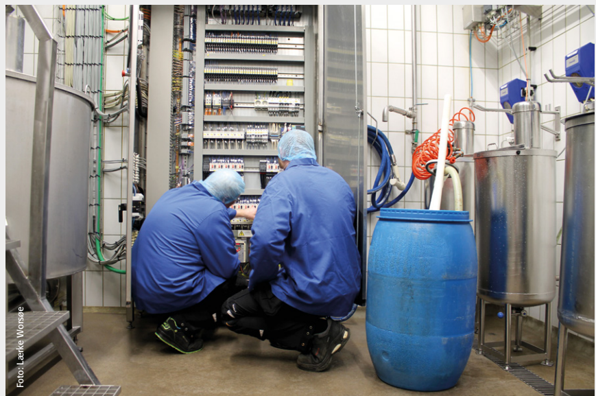
Elektriker Michael Aagurd (tv.) og smed Henrik Pape arbejder tæt sammen i det daglige, hvor arbejdet udspringer fra værkstederne, men udføres over alt rundt omkring på fabrikken.
